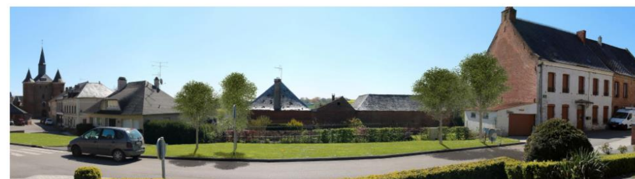
DEPUIS LES ABORDS DE LA MAIRIE DE PLOMION (PHOTOMONTAGE N°20) : SIMULATION DU PROJET AVEC MESURES DE RÉDUCTION DES IMPACTS Plantations d'arbustes aux abords de l'église Saint-Martin de Nampcelles-la-Cour
